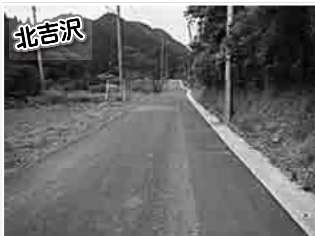
北吉沢 蓋のないU字溝への蓋設置
