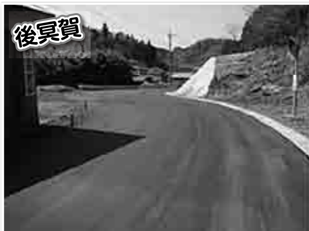
後冥賀 土手を削り幅員の狭いカーブを拡幅
