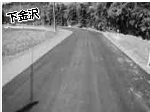
下金沢 歩道スペースへのカラー着色及び蓋のないU字溝への蓋設置
