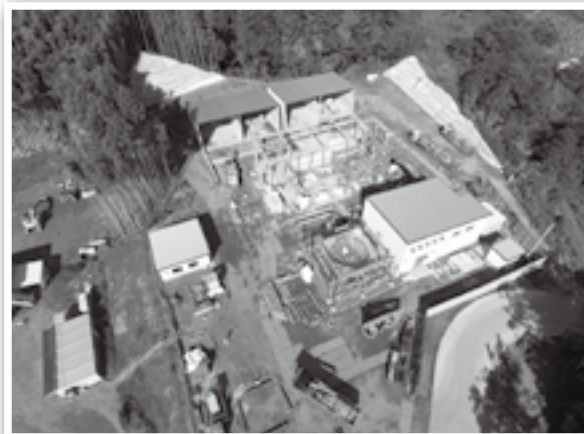
建設工事現場の様子 (上空から)
