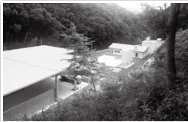
建設工事現場の様子 (西側町有林から)
