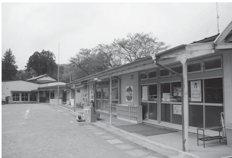
▲池田保育所（昭和49年3月建設）
