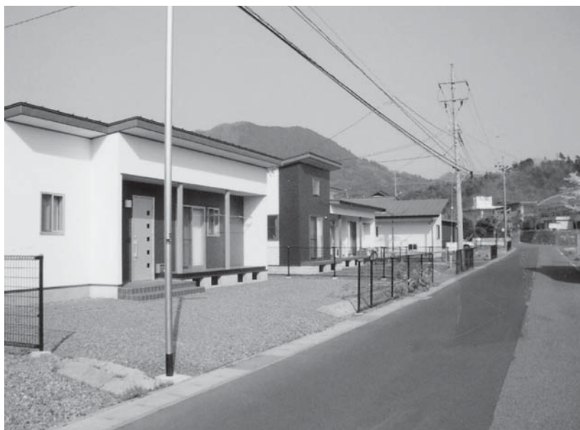
▲上小川町営住宅
