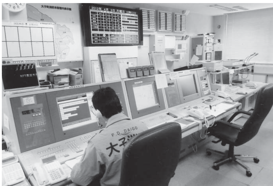
▲大子町消防本部通信指令室
