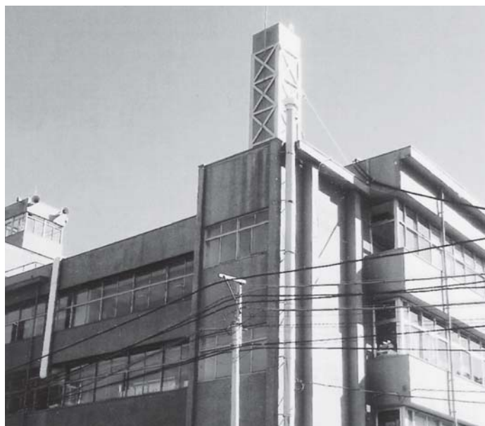
▲役場本庁舎煙突補強工事
