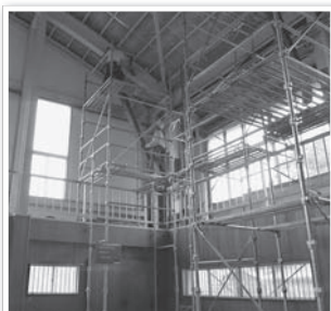
依上小学校（屋内運動場）
