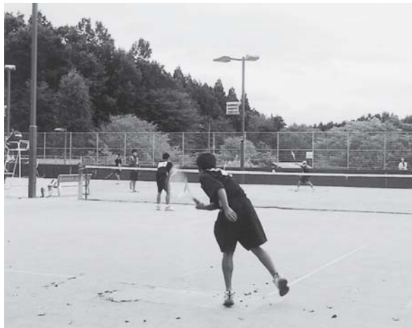
改修が望まれる大子広域公園テニスコート
