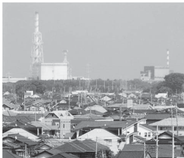
稼働後35年が経過し、老朽化した東海第二原発
