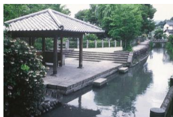
町堀を活用した親水公園の整備
