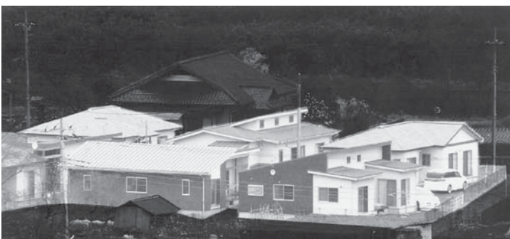
整備された子育て支援住宅
