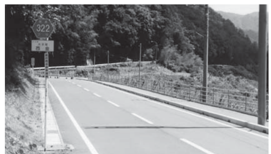
湯沢方面に道路改良が進む県道322号線
