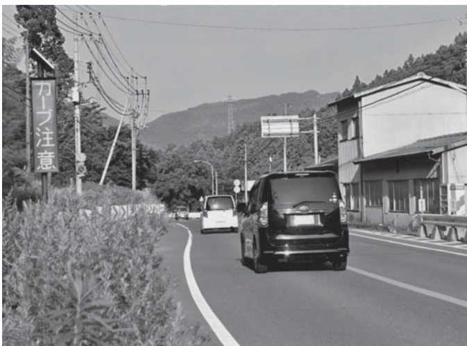
国道118号北田気地内
