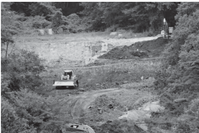
工事が進められる町有地
