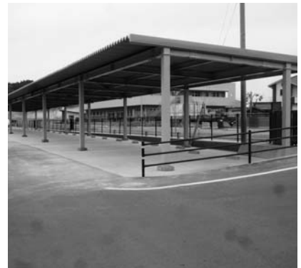
町公用車駐車場の整備
