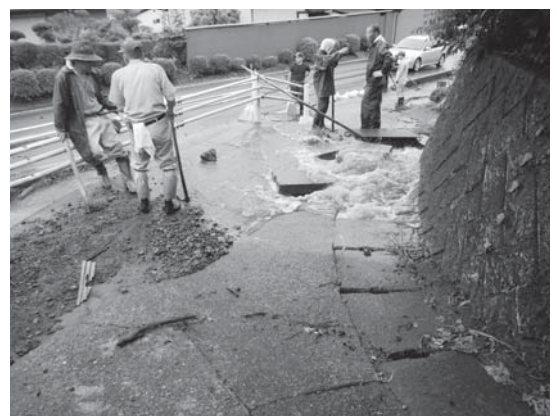
台風11号による被害（上金沢地内）
