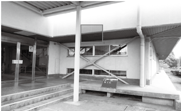
生瀬中学校耐震工事
