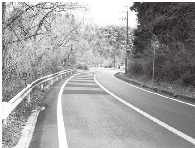
道路改良事業（北田気地内）
