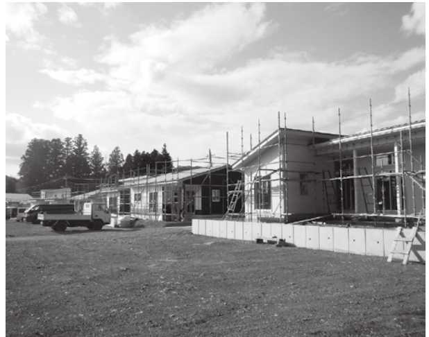
建設が進む子育て支援住宅
