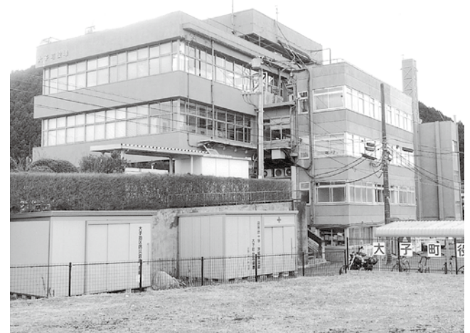
築後56年が経過している役場庁舎
