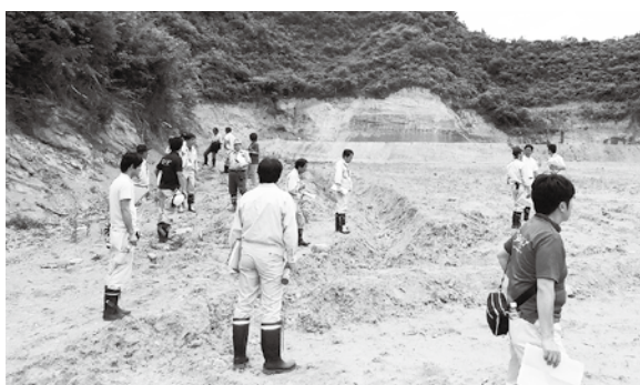
太陽光発電施設造成地を視察
