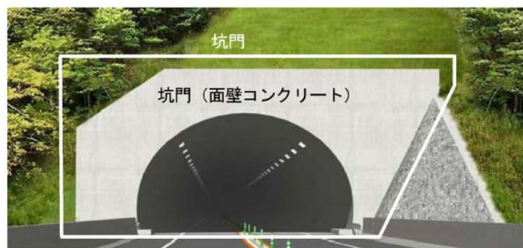
別図-1.2 点検対象箇所（トンネル坑口部）
