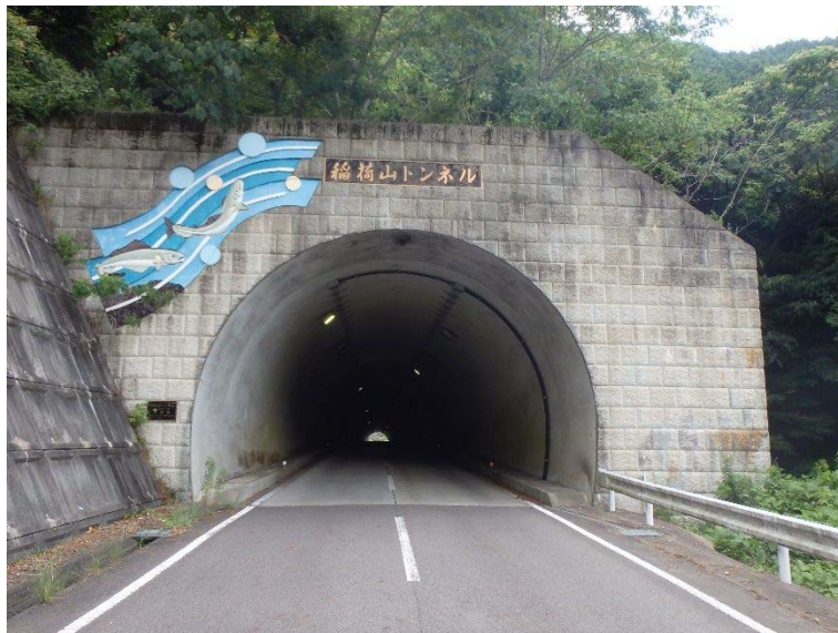
町道 2513 号線 稲荷山トンネル
