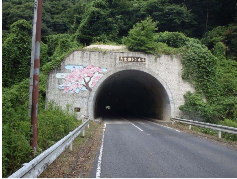
町道 3429 号線 大生瀬トンネル
