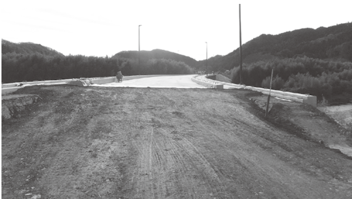
R118号袋田バイパス工事 (南田気地内)
