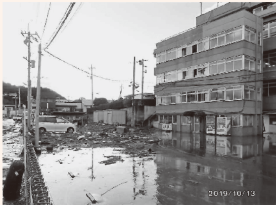
台風19号により浸水した庁舎
