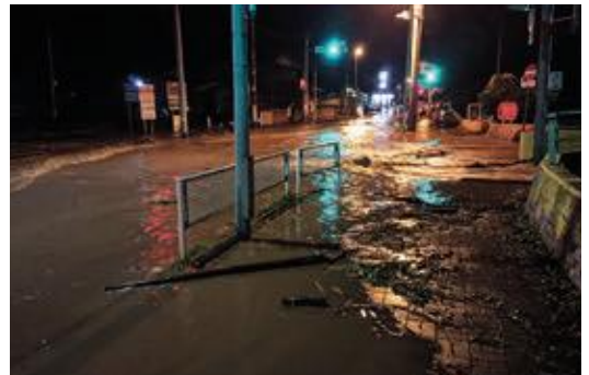
国道118号沿 松沼橋付近（13日1:00頃）
