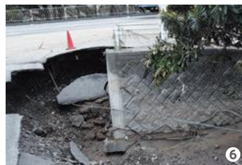
①久慈川の増水により崩落した JR 水郡線の第6 久慈川橋梁（久野瀬・南田気地内） ②地階部分が水没した役場庁舎 ③大量の泥に苦しむ町内（泉町） ④各地区から運び込まれた災害ごみ（中央公民館グラウンド） ⑤道路脇に流れ込んだ流木（袋田） ⑥冠水の影響で陥没した道路（西金）
