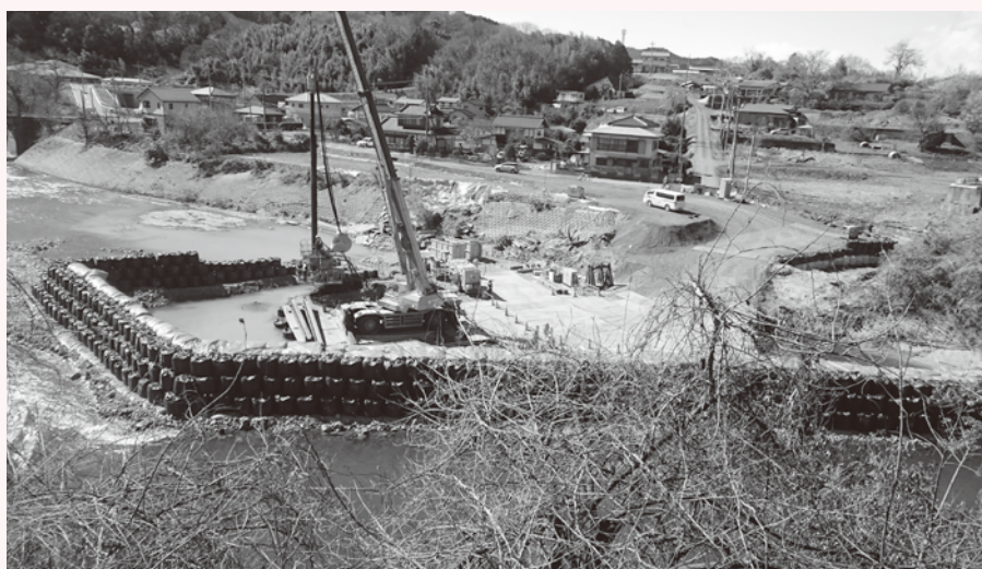
復興の槌音響く「袋田鉄橋の橋脚建設」
