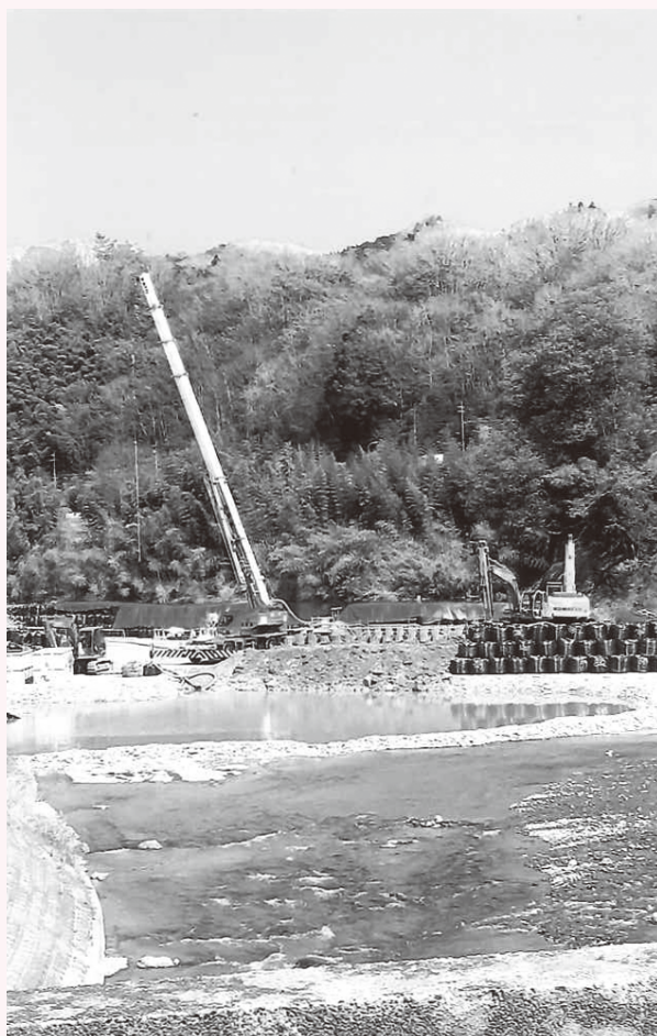
JR 水郡線鉄橋の再建工事(来年7月にトラス橋として完成)
