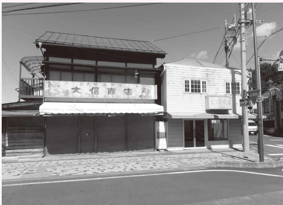
利活用が望まれる大子駅前空き店舗
