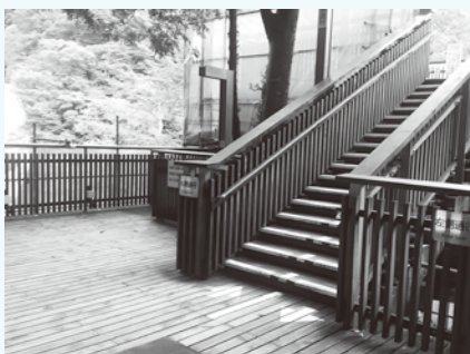
修繕予定の袋田の滝観瀑台
