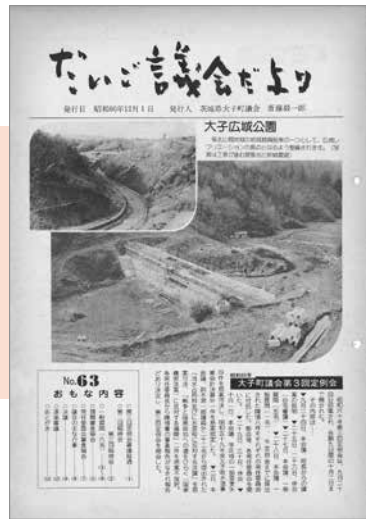
No. 63 「大子広域公園造成」
