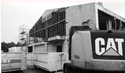
解体中の体育館
