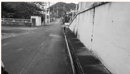
側溝のない町道
