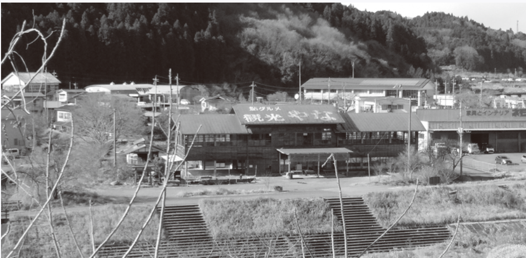
解体が決定した観光やなの建物
