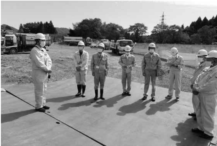
新庁舎建設に伴う進入路の現地解体状況視察
