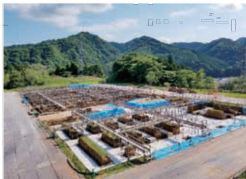
新庁舎建設工事全景
