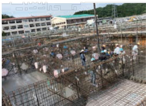
行政棟基礎コンクリート打設工事
