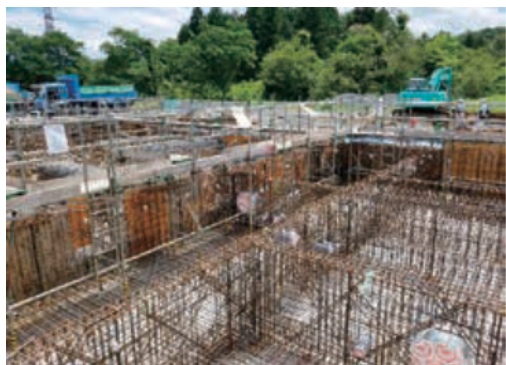
行政棟基礎配筋工事
