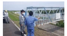
樋管の点検の様子
