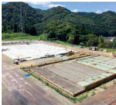
新庁舎建設工事全景
