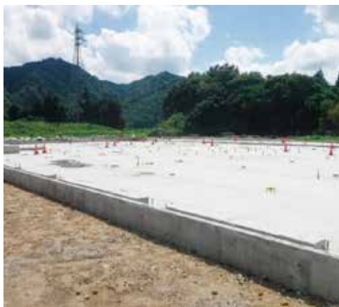
行政棟（立上りコンクリート打設工事）
