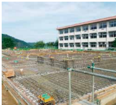
議会ホール棟（土間配筋工事）
