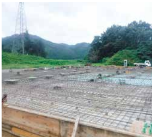
倉庫棟（土間配筋工事）
