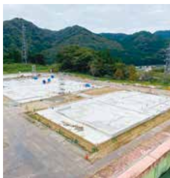
新庁舎建設工事全景
