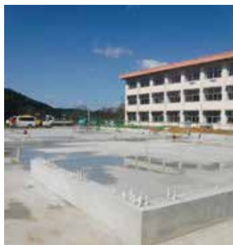
議会ホール棟
