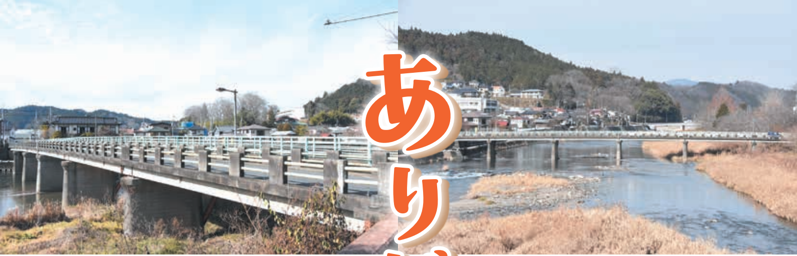
現在の松沼橋（国道 118 号線側から撮影）
