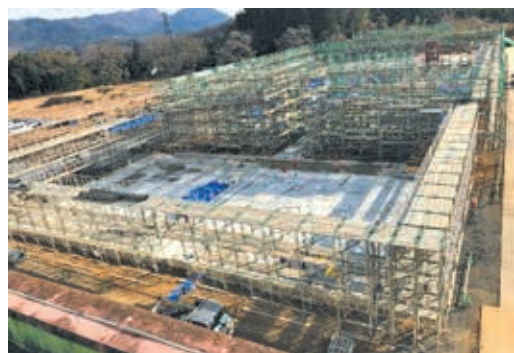
新庁舎建設工事全景
