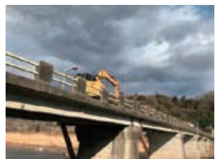
▲撤去工事の様子
