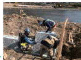
パワーアシストスーツ検証の様子▶
