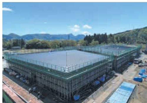
新庁舎建設工事全景
