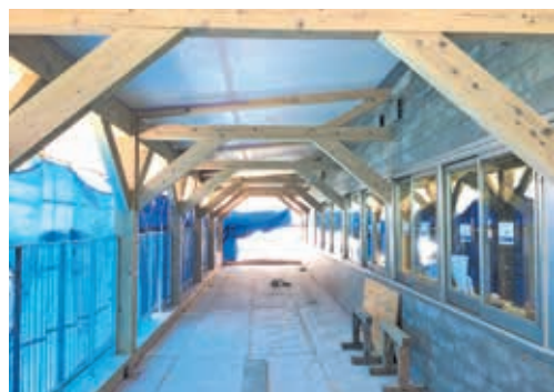
議会ホール棟 2階テラス部
