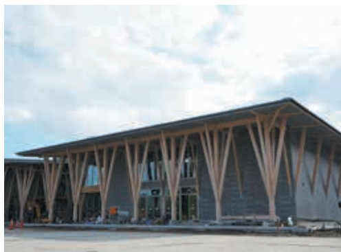
議会ホール棟
