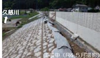
工事中 (R4.5月撮影)
