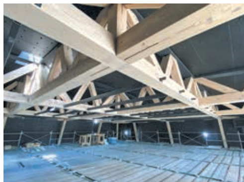
議会ホール棟 議場天井部
