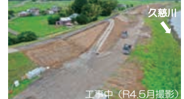
工事中 (R4.5月撮影)
