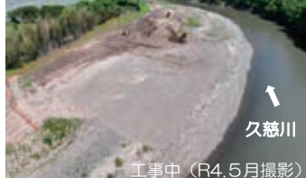
工事中 (R4.5月撮影)
