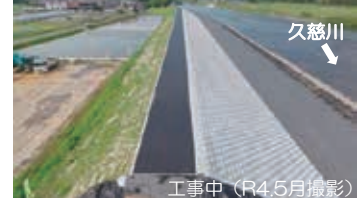
工事中 (R4.5月撮影)
