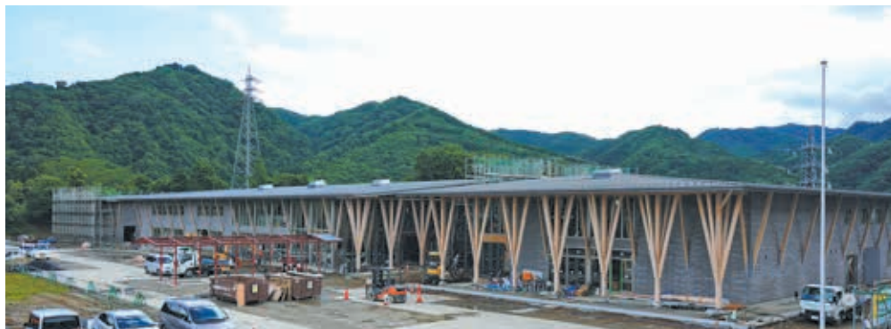
庁舎建設工事全景
