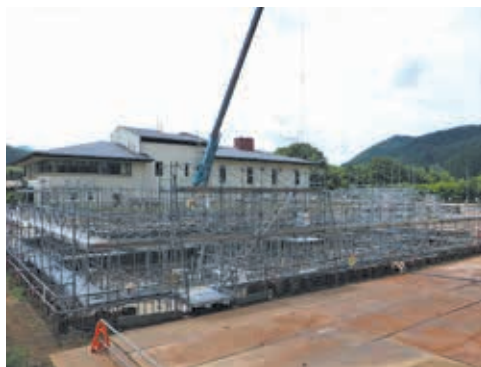
壁や柱の配筋作業のための足場を設置
