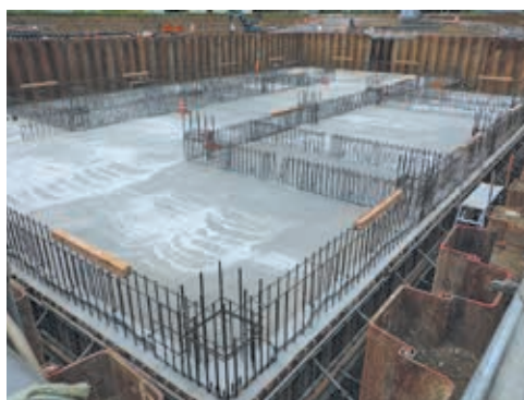
水槽底部のコンクリート部分
