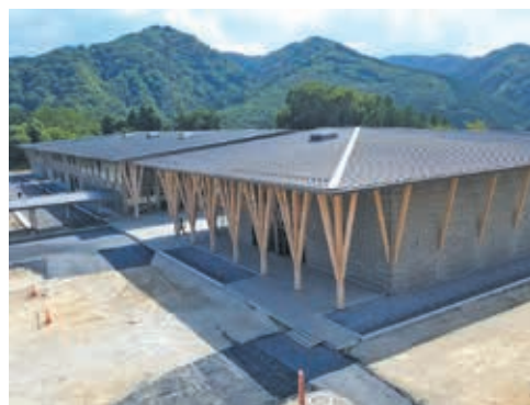
新庁舎建設工事全景
