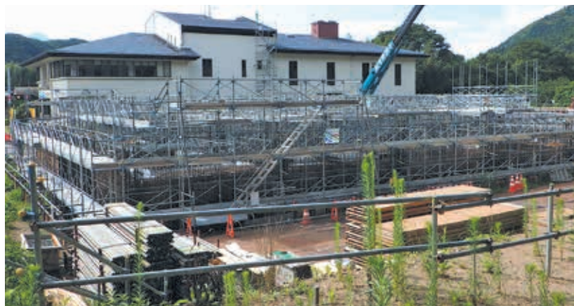
全体の足場および型枠設置状況
