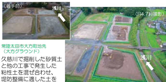
R3久慈川土砂改良(その1)工事／榊杉原建設
