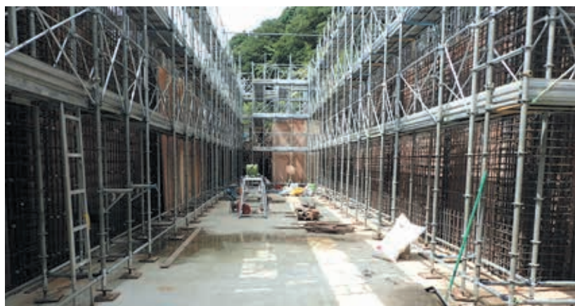
地階部足場および型枠設置状況
