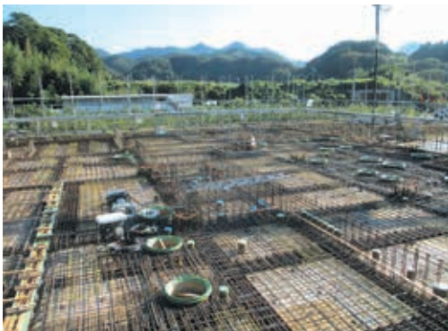
1階床部配筋状況
