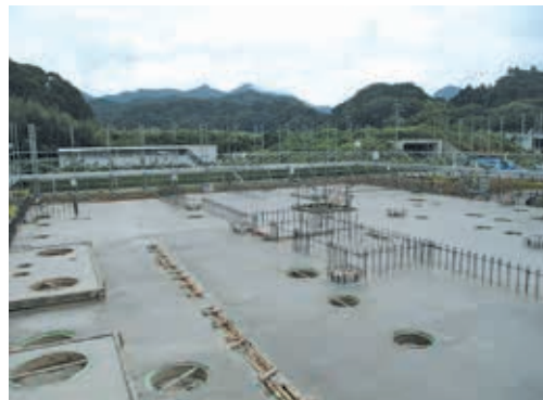
1階床部コンクリート打設状況
