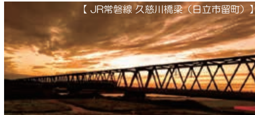
【JR常磐線 久慈川橋梁（日立市留町）】
