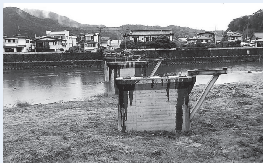
掛け替え予定の松沼橋
