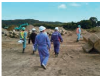
工事安全パトロールの様子▶
