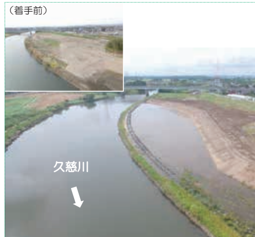
R3久慈川左岸下土木内町地先上流河道掘削工事 (樋口土木株式会社)
