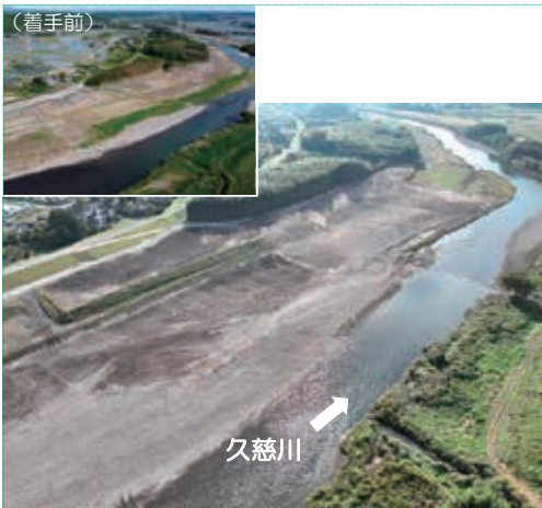
R3久慈川左岸宇留野地先河道掘削工事 (珂北開発株式会社)
