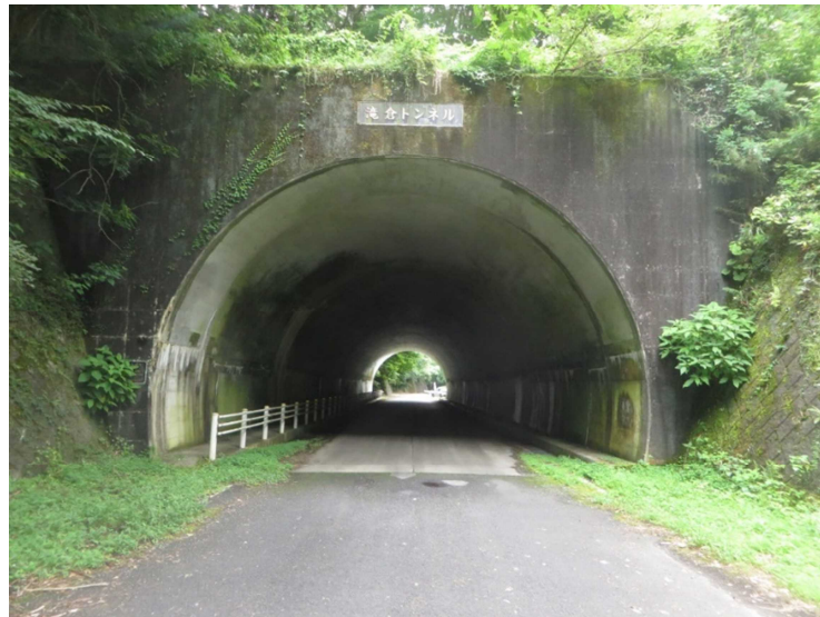
滝倉トンネル
