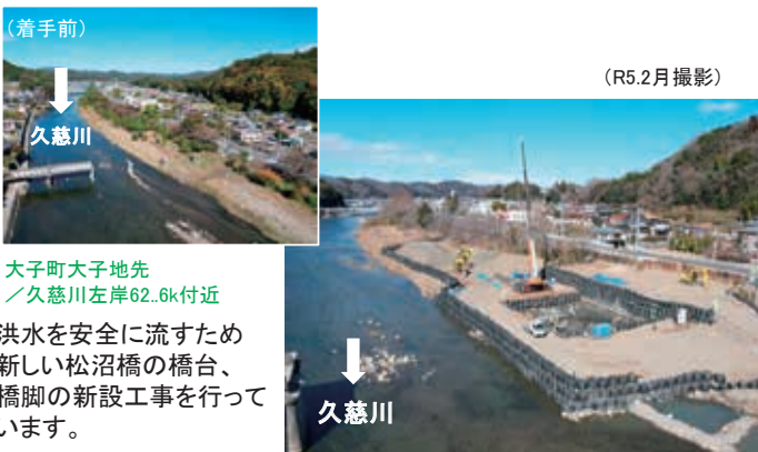
R3久慈川松沼橋下部工新設外工事／小林建設㈱
