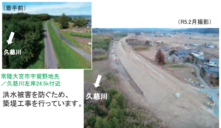
R3久慈川左岸宇留野地先築堤工事／増子建設㈱
