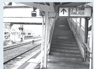
重い荷物を抱えて、跨線橋の階段を上り下りして移動しているのが現状
