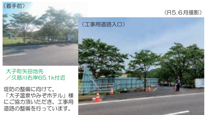
R4久慈川右岸矢田地区整備工事／株木建設㈱
