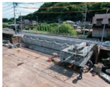
▲新規橋台(施工中)
