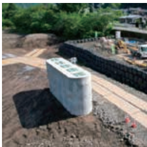
▲新規橋脚(完成)
