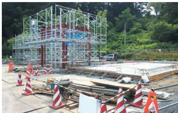
資源化施設土間下コンクリート打設状況
