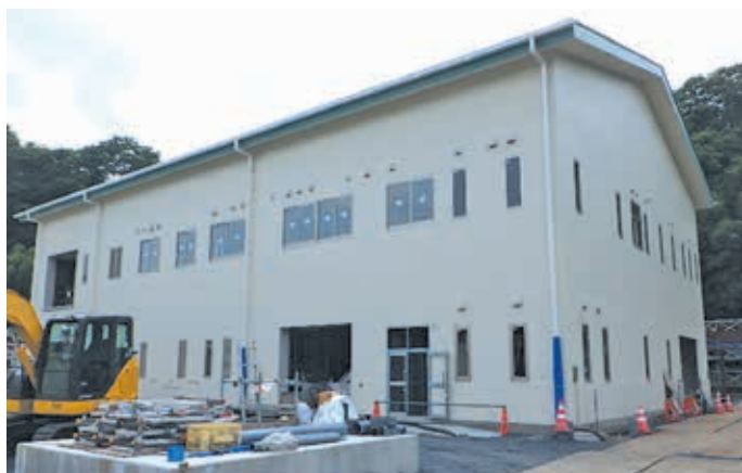
建屋外構状況
