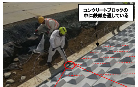
▼コンクリートブロック鉄線連結作業
