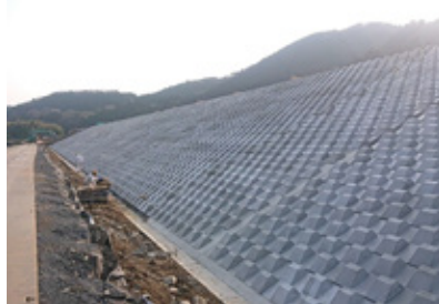
▲完成した護岸堤防
