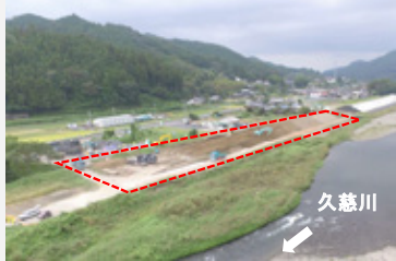
R4久慈川右岸舟生地先排水樋管改築外工事／樋口土木（株）
