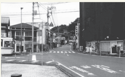
整備が進められる国道461号大子町内
