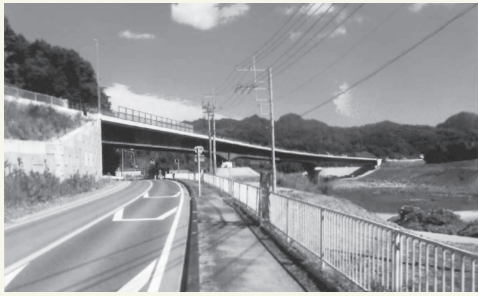
完成間近な国道118号袋田バイパス
