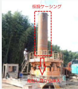
①杭を打つ箇所に仮設ケーシングを挿入、掘削します。
