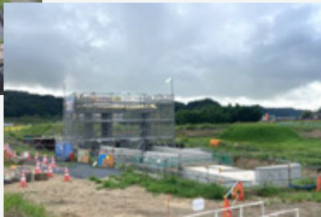
▲樋管全景(川裏側より撮影)
