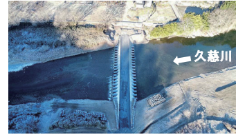
▲完成した渡河施設
