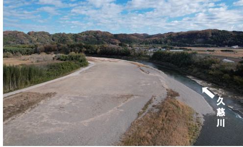
工事完了状況
