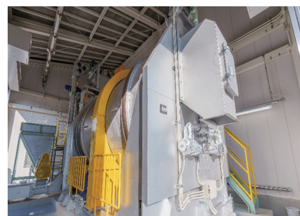
資源化施設の外観状況
