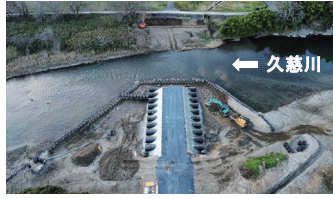
▲施工途中の渡河施設
