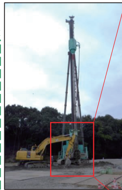
▲深層混合処理用重機
