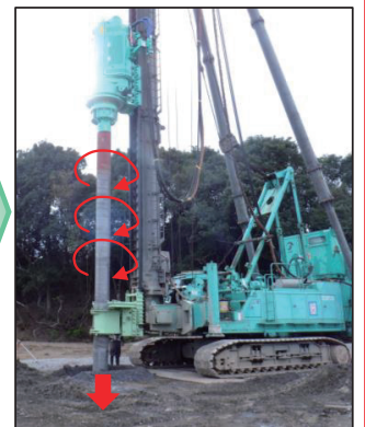
▲回転・攪拌しながらスラリーを注入
