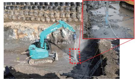
▲ダウンザホールハンマ工法による掘削状況
