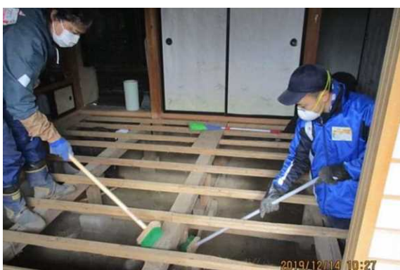
床下の泥出し作業
